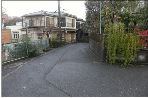
公道が下りきったところに3軒建っている現場。手前の道路にしか下水管が通っていない。
