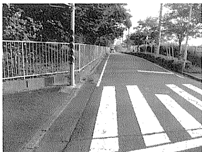
歩道設置の要望が出された道路
