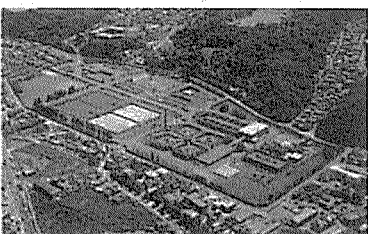
生田浄水場全景
