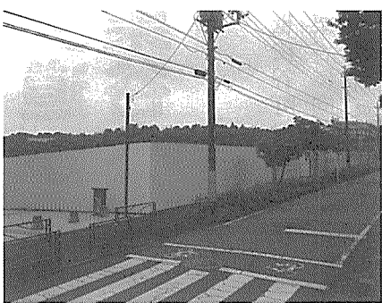
工事用の囲いができた建設予定地
