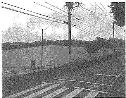
工事用の囲いができた建設予定地
